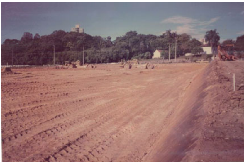
O terreno no bairro da Nova Rússia, em Ponta Grossa, onde foi construída uma loja de 4 mil metros quadrados de área de vendas
